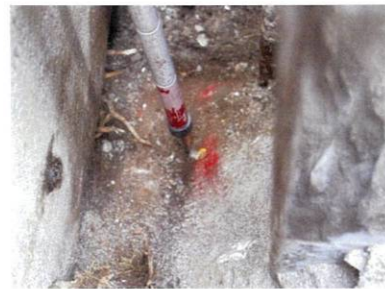
KP67 コンクリート杭
