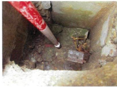
KP59 コンクリート杭
