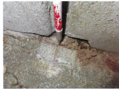
K60 コンクリート杭
