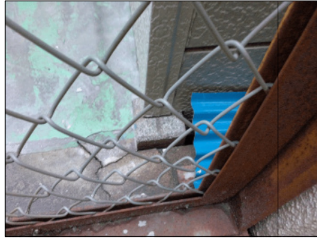
HM4 コンクリート杭
